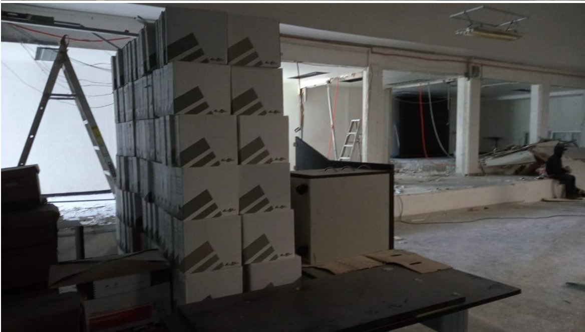
Movimiento y traslado del Archivo Institucional para habilitar espacio del Centro de Cultura Digital, previo a remodelación de edificio en Viaducto Río de las Avenidas no. 200, Col. Periodistas, en la ciudad de Pachuca de Soto, Hidalgo, México.
